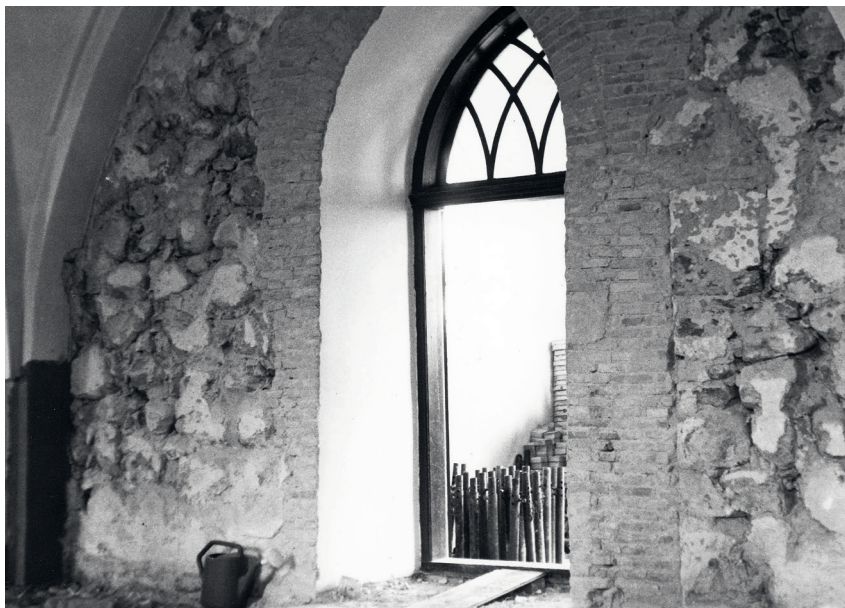
Fig. 10. Skibets bagmur afbanket for puds ved den indre istandsættelse 1966-67. Bemærk vangen til den romanske \dagger syddør til højre for døren (s. 4565). Foto Anders Ploug-Sørensen 1966/67. I NM. – The inner walls of the nave with the dressing knocked off at the refurbishing in 1966-67. Note the right jamb of the Romanesque \dagger south door.
