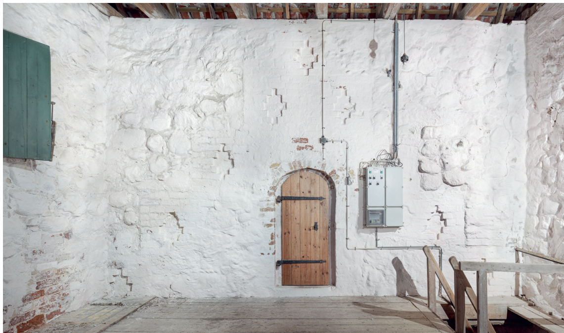
Fig. 11. Det udvidede skibs gavltrekant indmuret i tårnets østmur set mod øst (s. 4567). Foto Arnold Mikkelsen 2025. – The extended nave's gable embedded in the east wall of the tower, looking east.
