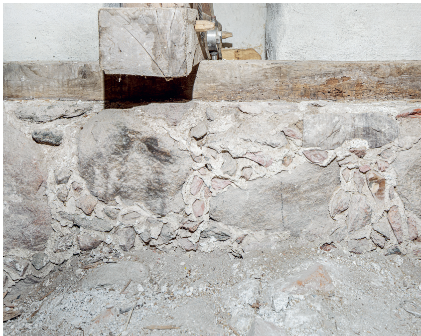
Fig. 21. Mulig murforhøjelse af skibet med indstukne teglstumper i fugerne set mod syd (s. 4567). Foto Arnold Mikkelsen 2025. – Possible heightening of the nave wall with embedded brick fragments in the joints, looking south.
