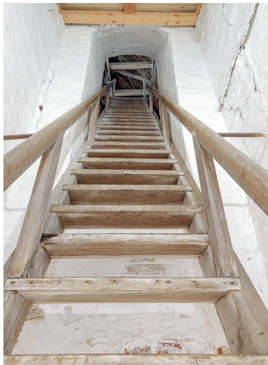
Fig. 19. Trappehusets indre set mod nord (s. 4571). Foto Arnold Mikkelsen 2025. – Stairwell interior, looking north.
